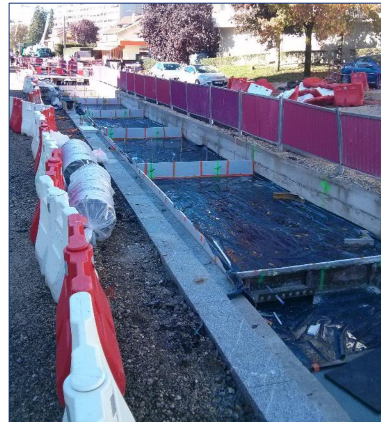
Pose du tapis anti vibratile avant réalisation de la plateforme
